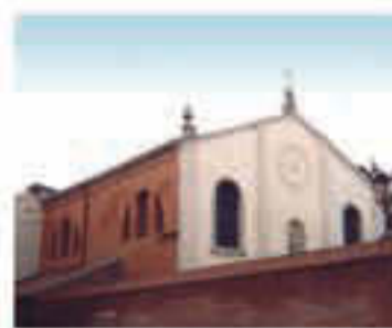
Chiesa S. Caterina - Chioggia (VE) Ristrutturazione chiesa e campanile
