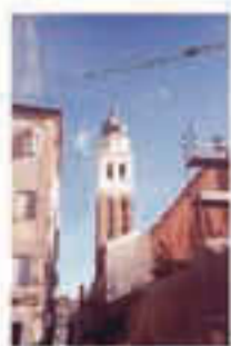
Chiesa S. Caterina - Chioggia (VE) Ristrutturazione chiesa e campanile
