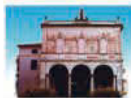
Teatro Comunale Piove di Sacco (PD) Lavori di ristrutturazione
