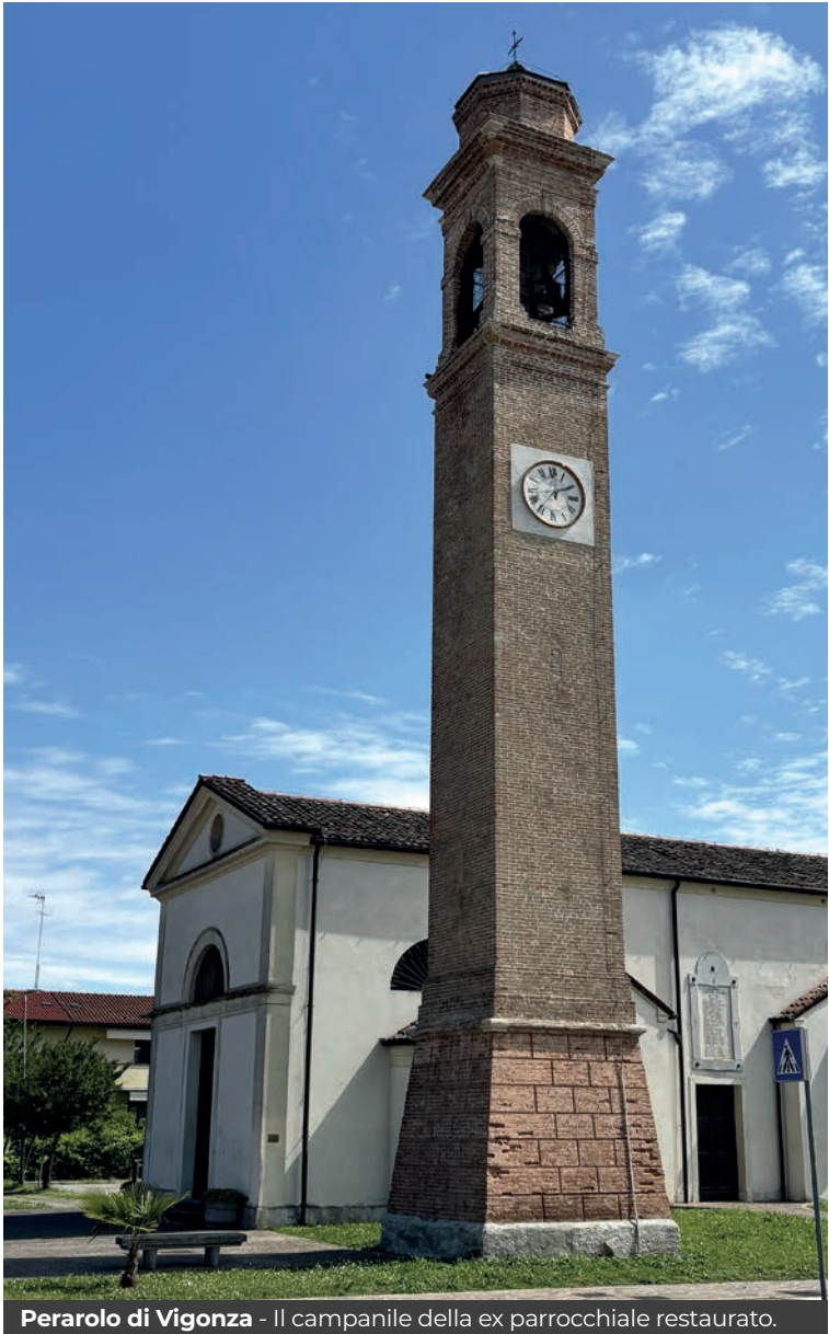
Perarolo di Vigonza - Il campanile della ex parrocchiale restaurato.
