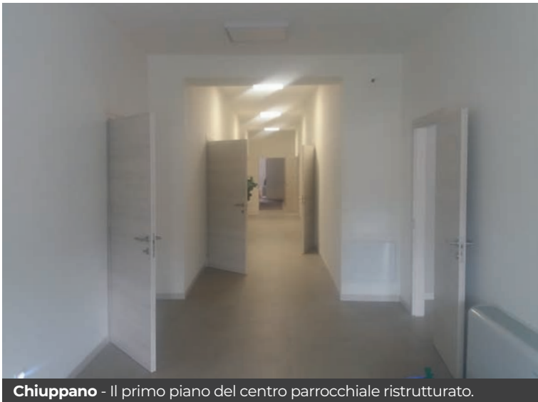
Chiuppano - Il primo piano del centro parrocchiale ristrutturato.
