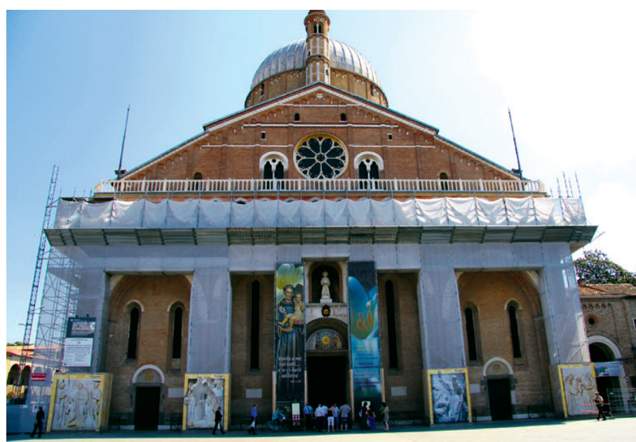
Restauro facciata Basilica di S. Antonio - Padova
