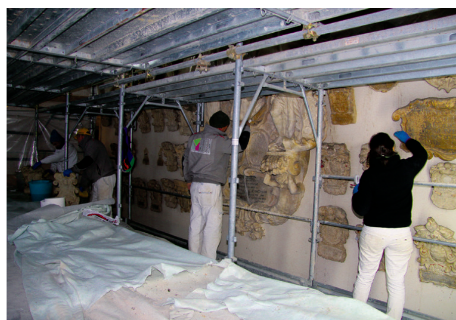
Restauro Cortile Antico del Palazzo del Bo - Padova
