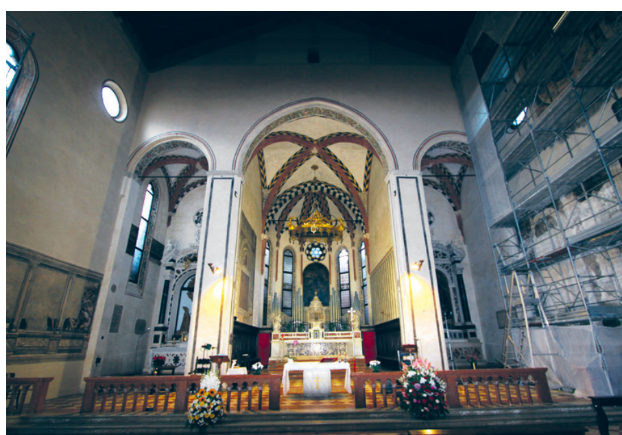
Restauro Chiesa di S. Maria ai Servi - Padova
