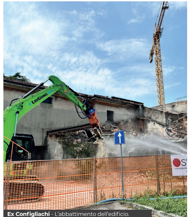
Ex Configliachi - L'abbattimento dell'edificio.
