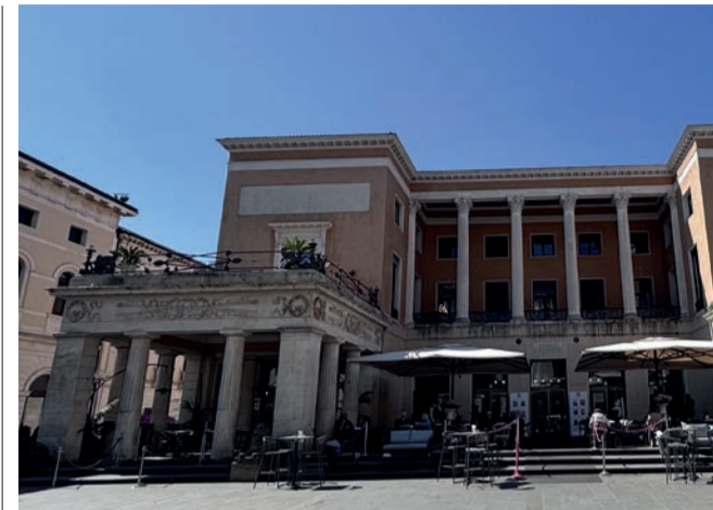
Il caffè Pedrocchi - La facciata neoclassica rivolta a nord.
